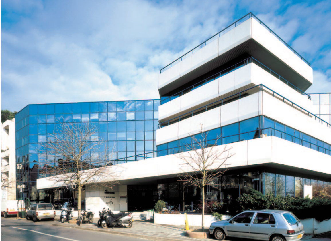
22 quai Galliéni • Suresnes (92)
